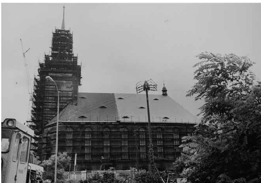
Obr. 7: Rekonstrukce věže kostela pro jeho přesunutí na nové místo (NA, f. MK, kart. 380, čj. 17565/83, příloha Dostavba gotického kostela v Mostě. Fotoinformace, foto č. 1)
