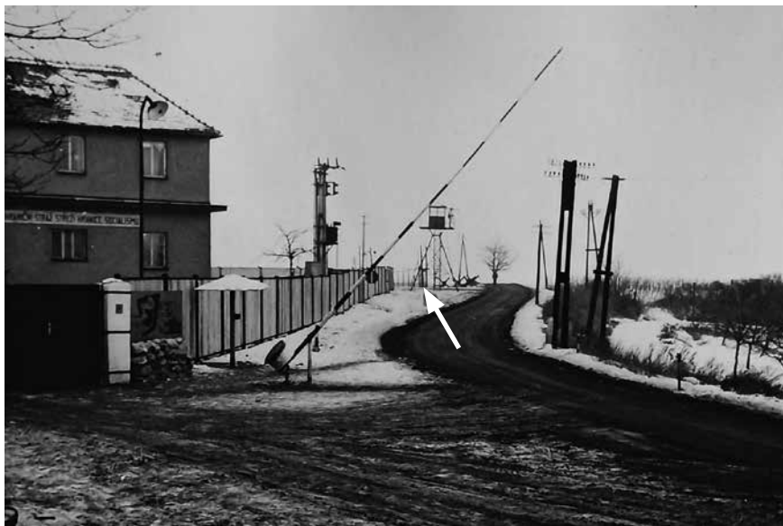
Obr. 7: Snímek prostoru stanoviště hlídky před útvarem. Šipka označuje místo průchodu ženině technickým zabezpečením, kterým pětice prošla (ABS, f. Správa vyšetřování StB – vyšetřovací spisy, arch. č. V-33532, dokumentace, s. 11)
