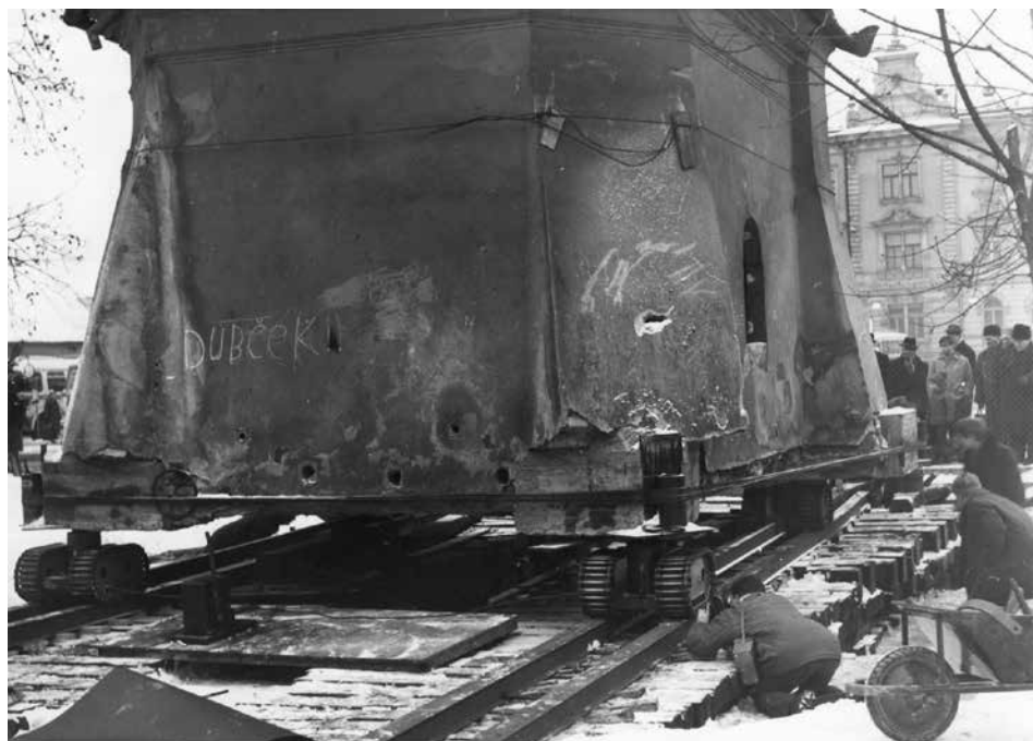
Obr. 6: Přesun kaple sv. Šebestiána v Uherském Hradišti, detail transportních „tančičků“ (Slovácké muzeum v Uherském Hradišti, fotoarchiv, inv. č. 38285)
